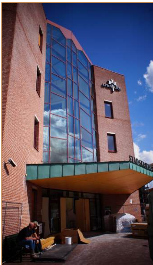
Het stadskantoor oude hoofdingang tijdens verbouwing 2025
