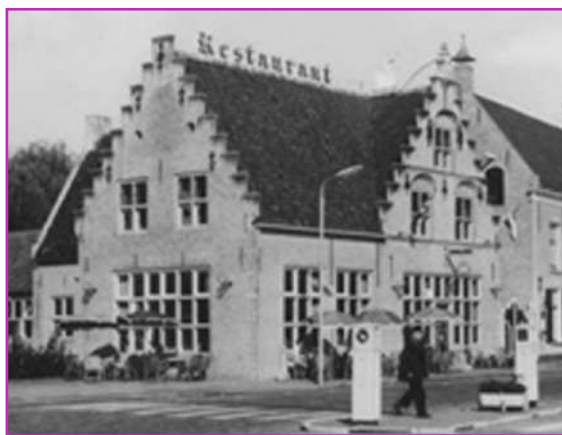
Restaurant De Zwaan na de renovatie
